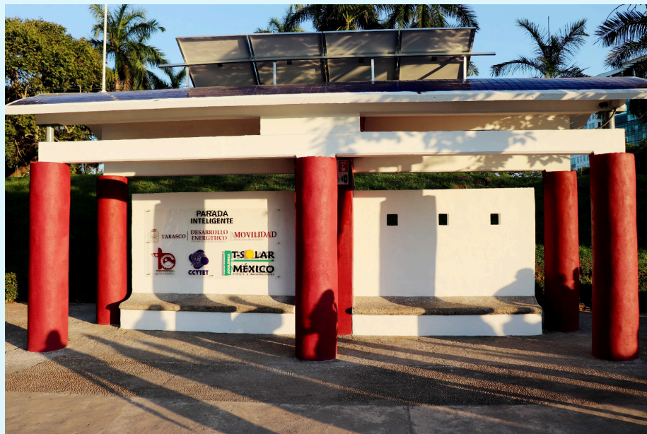
"Parada inteligente" ubicado en avenida Ruiz Cortínez en Villahermosa, Tabasco.
