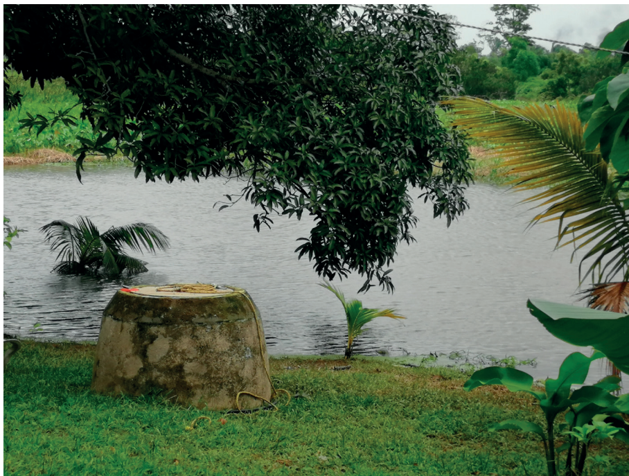
2 Drenajes que vierten sus aguas residuales a los humedales
