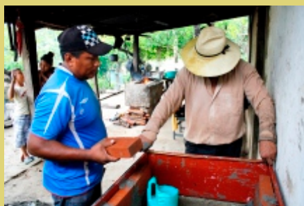
Figura 5. Familiares de la usuaria construyendo una estufa Patsari. Secc. Pochote del Ej. E. Zapata.
